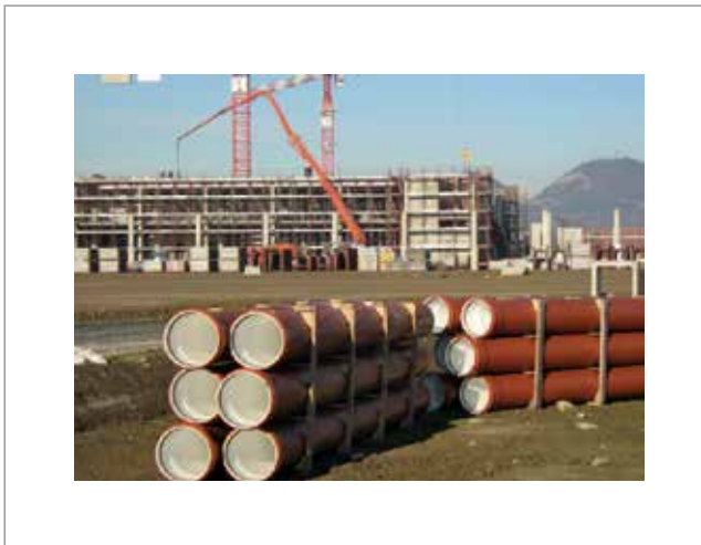
Tubi TriPPlo+ pronti ad essere installati
