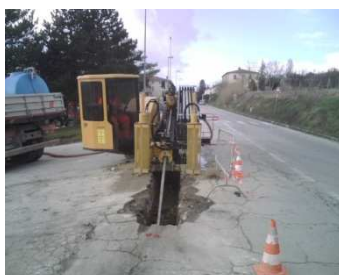
Sotto: immagini di utilizzo di tubo Polier in lavori con tecnologia no-dig e terminali di sonde geotermiche realizzate con POLIER
