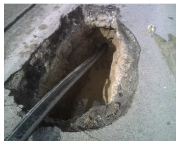
Sotto: immagini di utilizzo di tubo Polier in lavori con tecnologia no-dig e terminali di sonde geotermiche realizzate con POLIER
