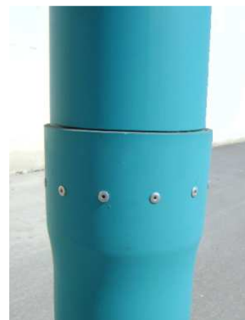
De gauche: Ecopozzo fileté, les trois couches de la paroi de Ecopozzo, jonction à emboîtement (ici avec fixation à rivets)
